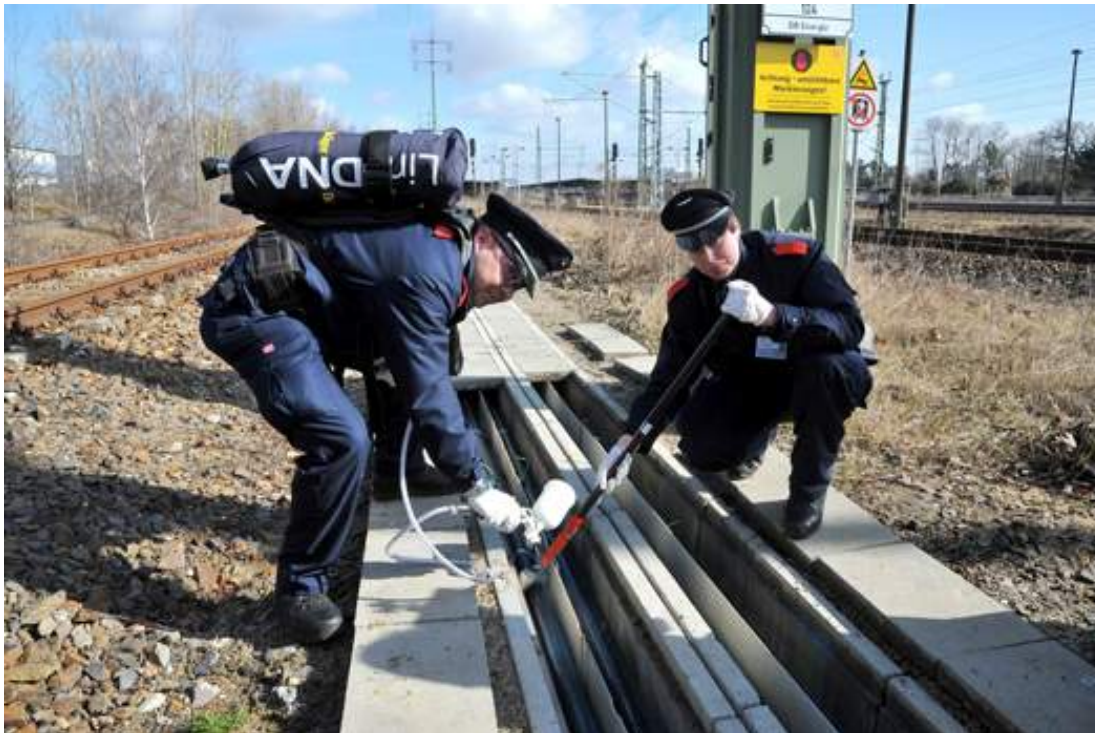
Auftragene künstliche DNA erschwert Buntmetalldiebstahl
